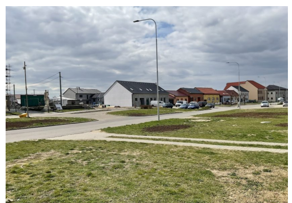
Pohled přes prázdné předzahrádky na hospodu a proluku
