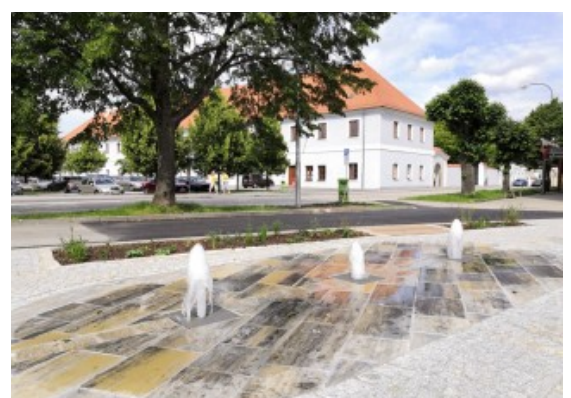
Vodní trysky zapuštěné v dlažbě
