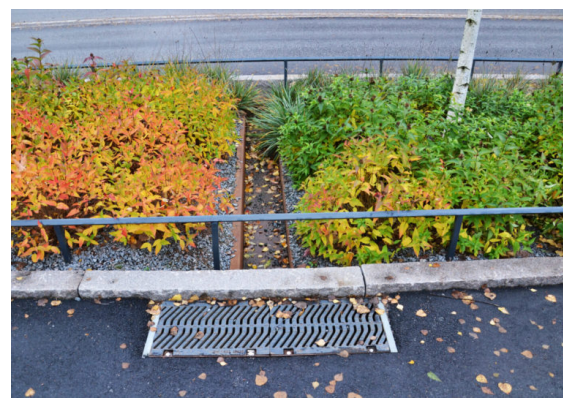
Odvod dešťových vod u dešťového záhonu
