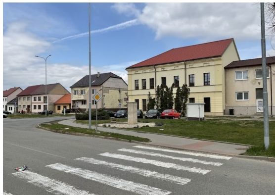
Přechod od základní školy posunutý od křižovatky
