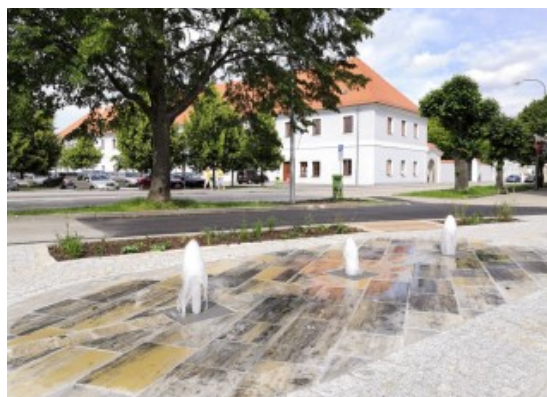
Vodní trysky zapuštěné v dlažbě
