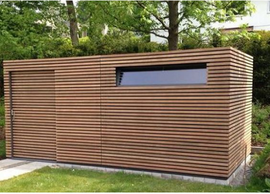
objekty s dřevěnou fasádou, příklad soc. zázemí
